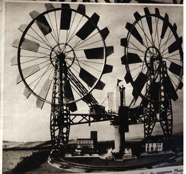
Ungeheure ungenutzte Kräfte schlummern im Wind. Sie übertreffen die gesamten Flusswasserkräfte der Erde um ein Vielfaches, werden aber, abgesehen von den wenigen Windmühlen, Windrädern und Segelschiffen, kaum ausgenutzt. Beim heutigen Stand der Technik wäre ihre Umwandlung in elektrische Energie — z. B. durch das hier abgebildete Bendmann-Projekt — durchaus möglich. Durch Sonnenmotoren, Wärmepumpen usw. könnten auch die ungeheuren, von der Sonne unabhnglich auf die Erde geschleuderten Energien zur Ersetzung der Kohle als Energiespender herangezogen werden.
